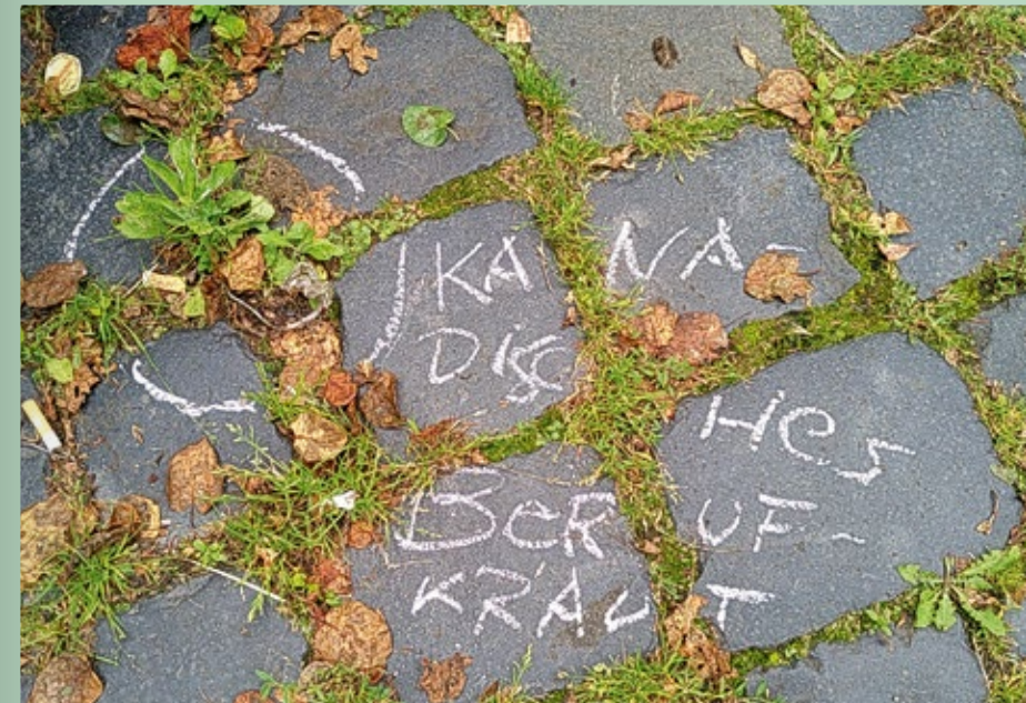
Entgegen dem Vorurteil, Pflanzen würden das Pflaster beschädigen, wird der Pflasterverbund durch das Vorhandensein eines dichten Bewuchses zwischen den Steinen sogar gefestigt.
